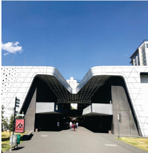
Figura 1 - Entrada de pedestres da Cineteca Nacional, fonte: os autores (2019).
