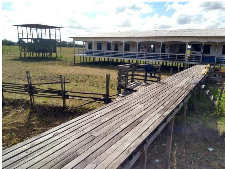
Fig. 17 Edifício da Escola Edmar Barbosa, no Alto Cururu, Marajó Fonte: foto do autor Novembro 2017
