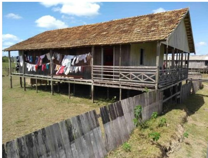
Fig. 11 Casa com palafitas no Alto Cururu Fonte: foto do autor, Novembro 2017
