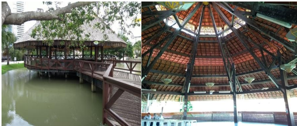
Fig. 13 e 14 Edifícios em madeira em Belém - Memorial dos Povos Indígenas e Restaurante da UFPA- mostram materiais tradicionais em sua reinvenção contemporânea. Fonte: fotos do autor, Janeiro 2018
